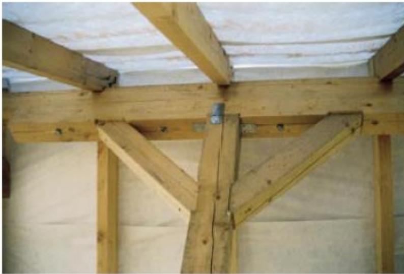
Obr. 2.56 Podoprení vrcholové väznice sloupkem, zavětřování diagonálními pásky [8]
