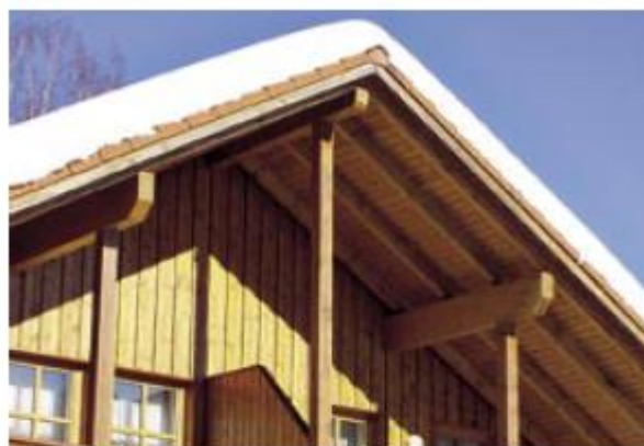
Obr. 2.60 Podepření vaznic při vyložení [1]
