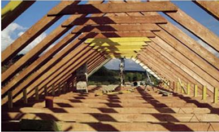
Obr. 2. 65 Vazba hambalkového krovu [1]
