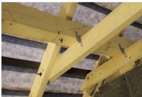
Obr. 2.58 Osedláni vaznice ve spojení s kleštinou [1]
