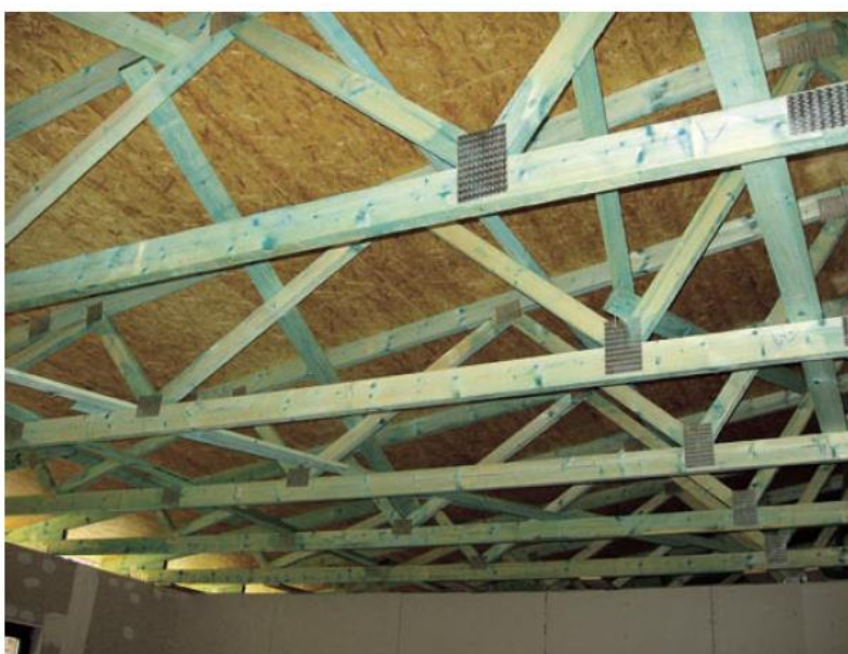
Obr. 2.69 Realizace priehradového vážniku se styčnickovými deskami s prilisovanými hrotmi [2]
